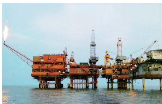
| 陆丰 14-4&15-1 7000 米模块钻机项目
