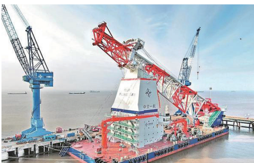
一航津桩 140 米打桩船
